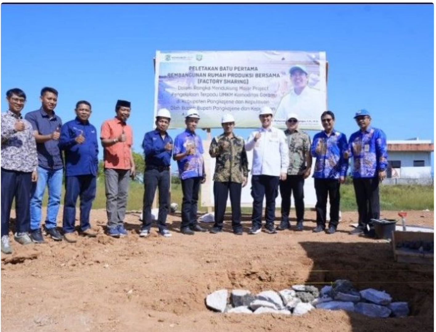
Peletakan Batu Pertama Pembangunan RPB Pengelolaan Garam
